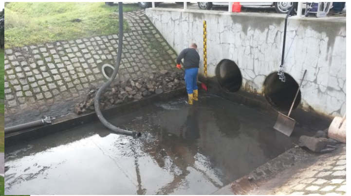
Foto 4: Auslaufbauwerk bei Revision
