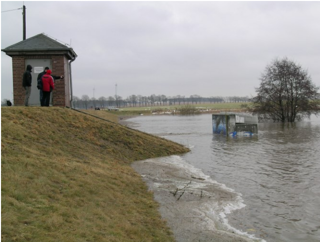
Foto 1: HWRB beim Hochwasser 2006
