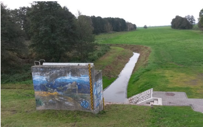
Foto 3: Einlaufbauwerk bei Beckenschau 2014
